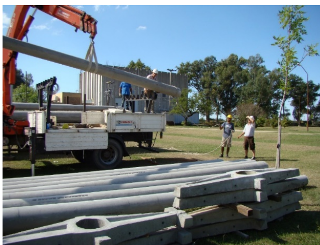
Figura 1, descarga de los postes y crucetas.
