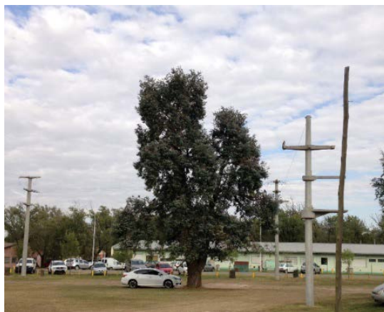
Figura 4, Estado del campo experimental una vez tendidas las líneas desnudas.
