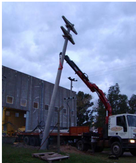
Figura 3, Izado de los postes y colocación en la fundación.
