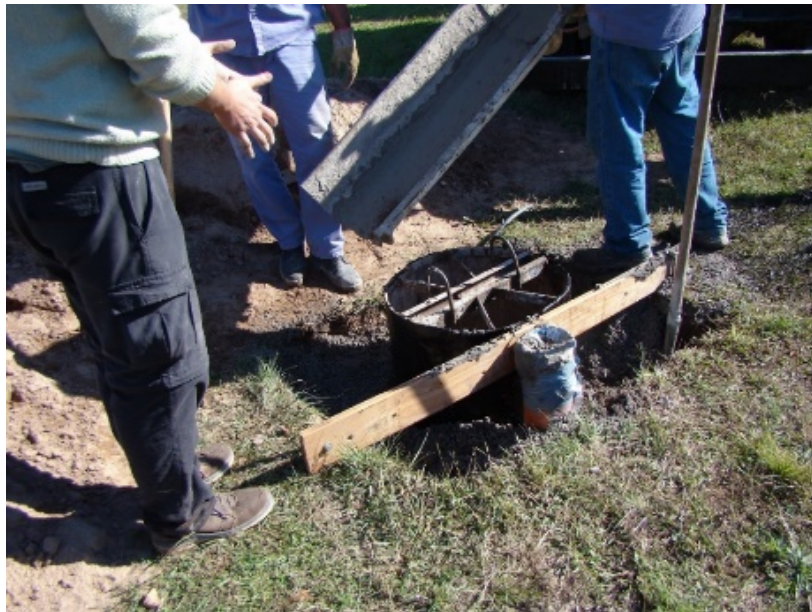
Figura 2, llenado de las fundaciones con hormigón.
