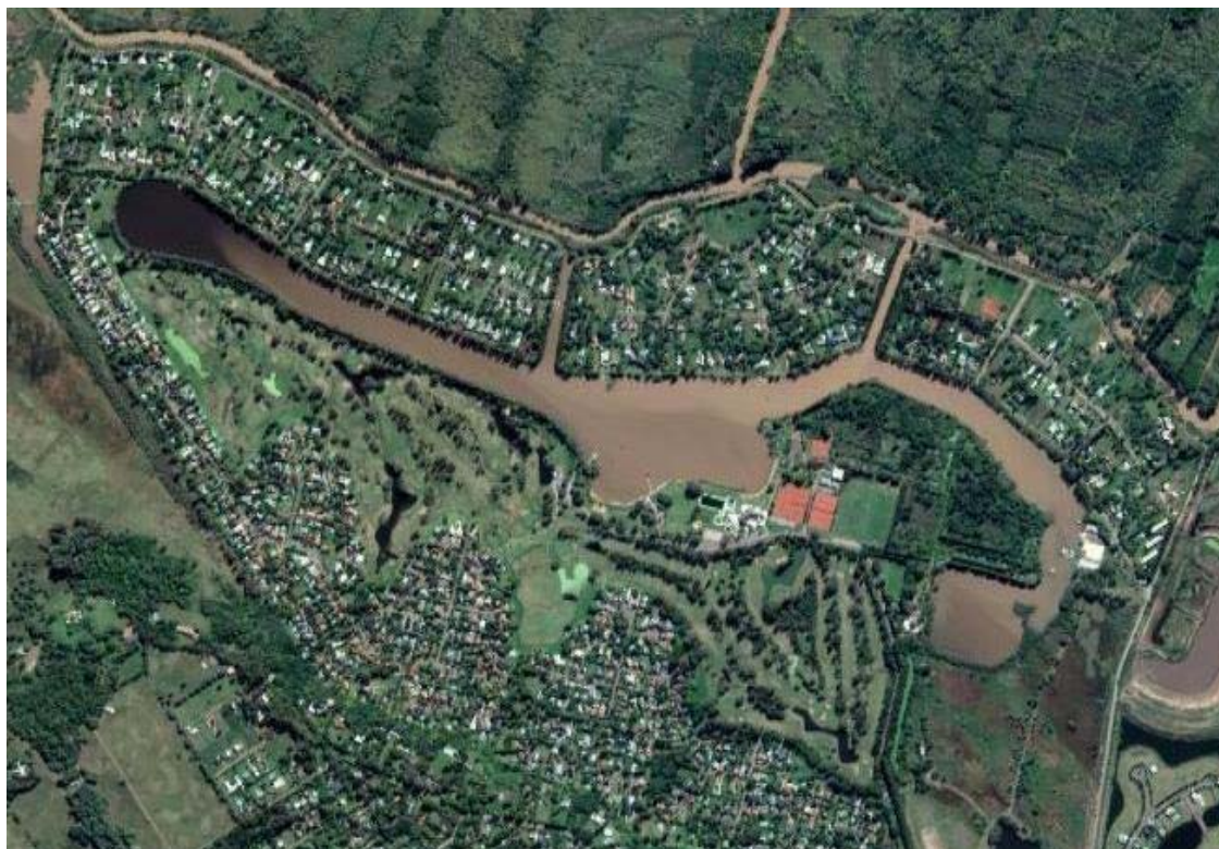
Figura 1. Vista aérea del barrio cerrado en estudio
