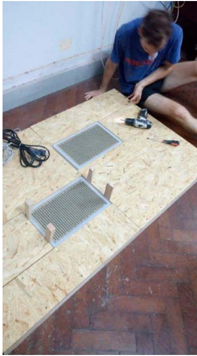
Figura 18. Instalación de pedígrafos en pasarela del Laboratorio de marcha implementado en CeTAD Fuente: elaboración propia
