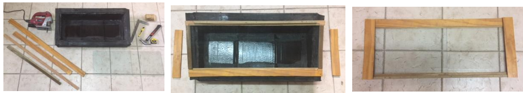
Figura 6. Construcción del bastidor y construcción con vidrio [5].
