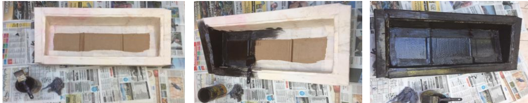
Figura 5. Caja entelada y reforzada lista para pintar (izq.). Pintado y acabado final (centro y der.) [4], [5]
