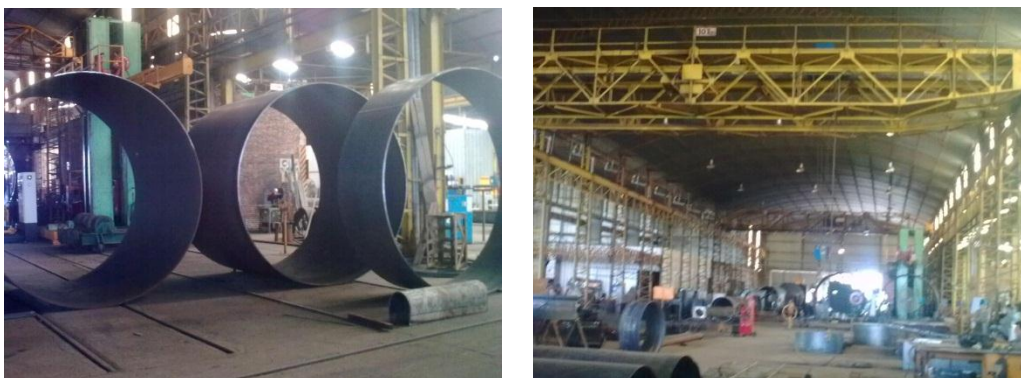
Fig. 3. Vista de parte de un tanque en chapa rolada de acero y del puente grúa (fuente propia)
